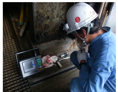
図. 柱の板厚計測状況
