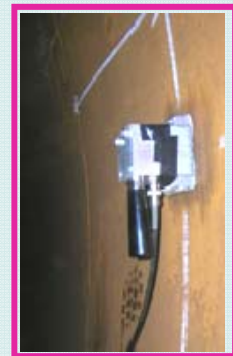
電磁超音波センサ設置状況
