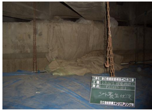
4 防爆・防音シート養生
