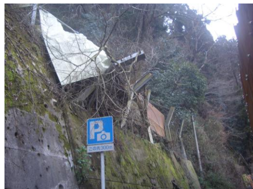
4 防爆・防音シート養生
