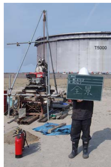
ボーリング調査
