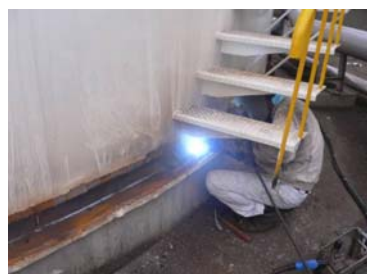
改修工事(溶接)
