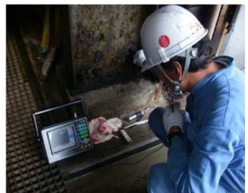
図. 柱の板厚計測状況
