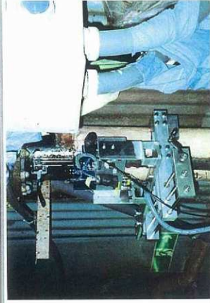
ドレン管（水圧鉄管付属設備）測定状況
