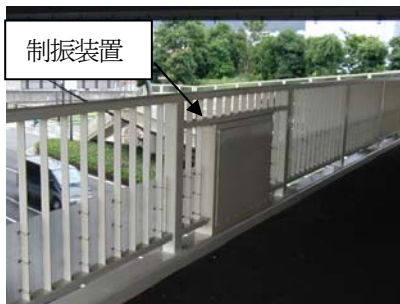
図12 高欄設置型 TMD
