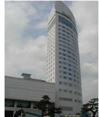
図13 対象とした 20 階建のビル
