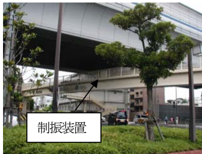
図11 A歩道橋 (TMD 設置後)
